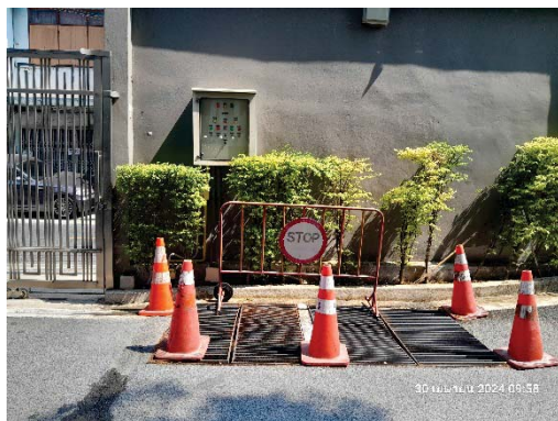
บ่อบำบัดน้ำเสียก่อนระบายออกนอกโครงการ และ ตู้ควบคุมการทำงานของเครื่องสูบน้ำ
